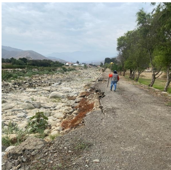
FIGURA N° 03: EN LA TEMPORADA DE MAXIMAS AVENIDAS, EL RÍO LA CUESTA SE DESBORDA EN ESTE TRAMO DEL SECTOR PEDREGAL, ARRASANDO CON TODO LO QUE ENCUENTRA A SU PASO, ACA SE VE LA EROSION DE LA VIA ADYACENTE.
